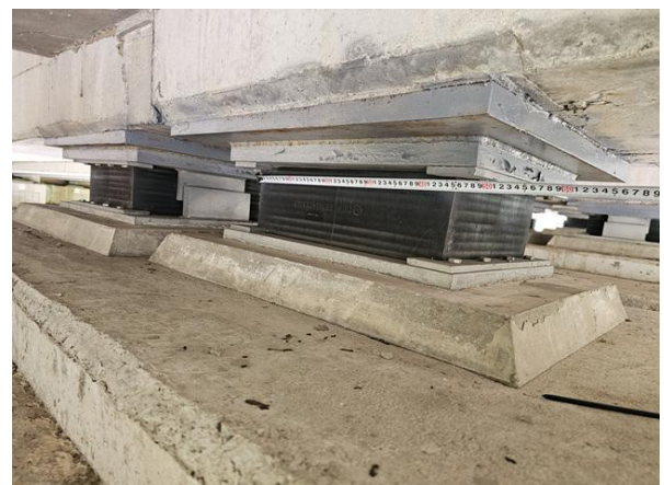
교량받침 이동량 측정
