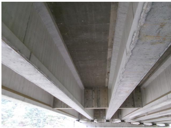
거더 및 바닥판하면 전경
