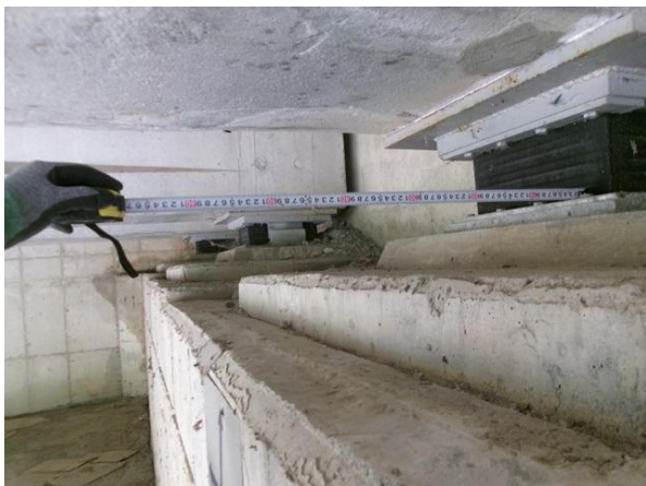
교량받침 제원 측정
